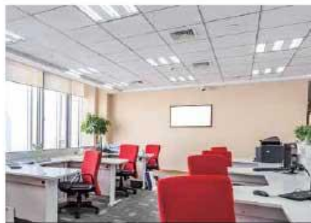
Dàn lạnh nổi ống gió với áp suất tĩnh trung bình
